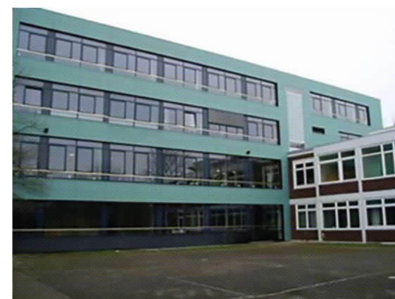
De panelen waren afkomstig van een voormalig jeugdcentrum ...
