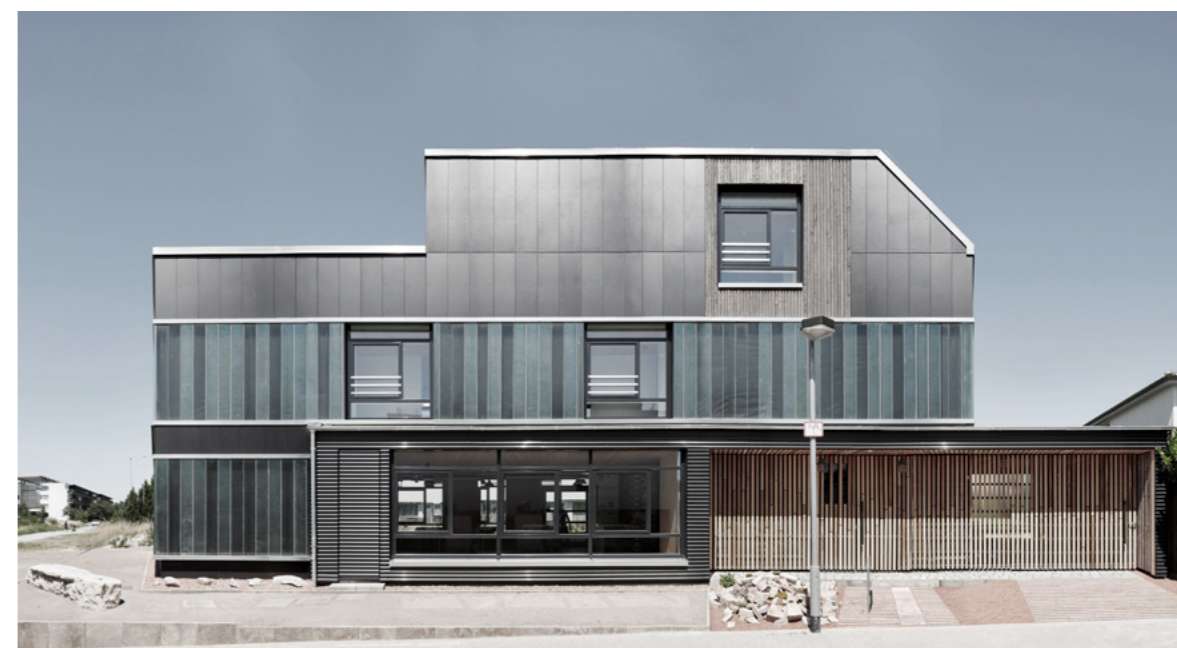
... en werden hergebruikt voor gevelbekleding [90% gerecycleerd] van een woning.
