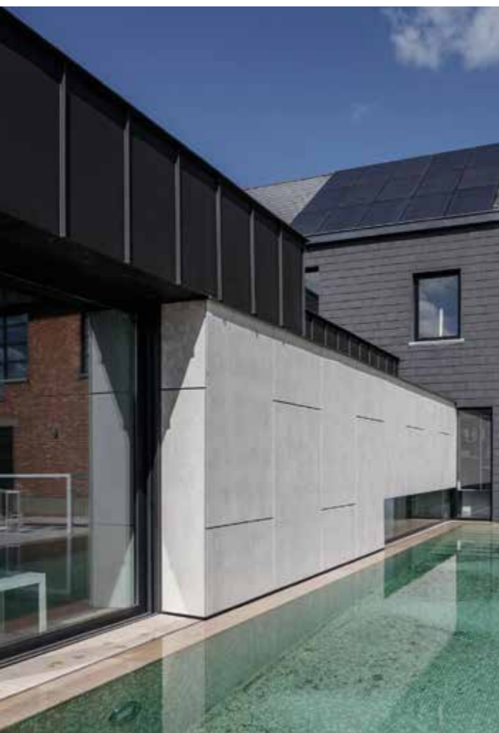
Architect: Reid Senepart Architecten Locatie: Dendermonde, België
