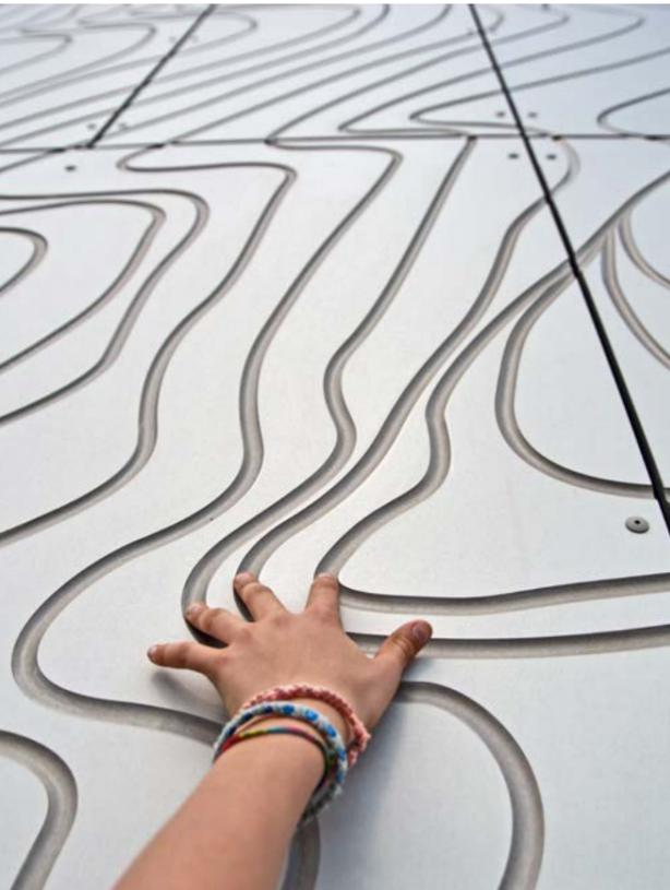
Geprägt von einer Gebäudehülle aus cremeweißen Faserzementtafeln, überzeugt die zweigeschossige Kindertagesstätte in München-Aubing durch ihre Schlichtheit und Robustheit. Der Neubau wurde in Systembauweise konzipiert und mit einer vorgehängten hinterlüfteten Fassade bekleidet, die nicht nur eine effiziente energetische Lösung bietet, sondern auch Kostenvorteile und eine kurze Bauzeit ermöglichte.
