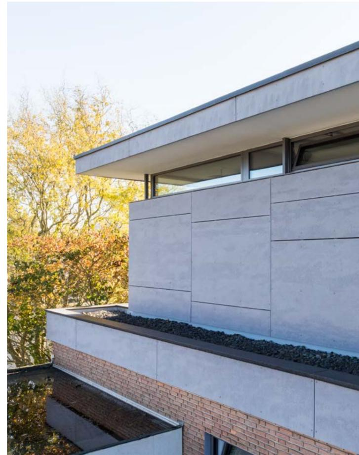
Durch die Setzung eines durchgehenden Oberlichtbandes unterhalb des auskragenden Daches erscheinen die geschlossenen Bauteile wie vorgesetzte Mauern, die dementsprechend mit Faserzementtafeln bekleidet wurden und vor allem zur Straßenseite sichtbar sind. Die hellgraue Färbung, sowohl der Tafeln aus Faserzement als auch der Fensterrahmen, drängt sich nicht in den Vordergrund und fügt sich gut in den Bestand ein.
