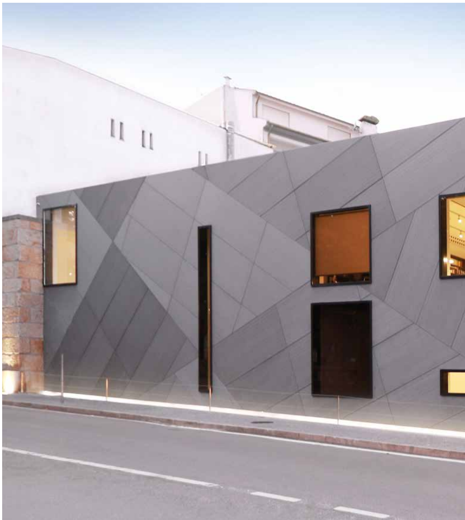
Santa Casa da Misericórdia de Valpaços Architekten: Santos-Gaia Arquitectos Produkt: Fassadentafeln EQUITONE [linea] Foto: Plot Twist
