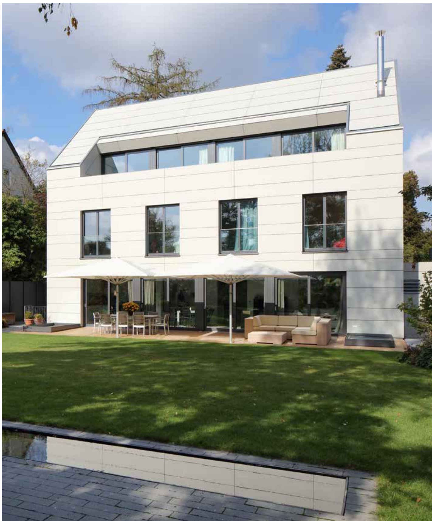
Einfamilienhaus K3, Stuttgart Architekten: Bottega + Ehrhardt Architekten Produkt: Fassadentafeln EQUITONE [natura] PRO Foto: Conne van d'Grachten
