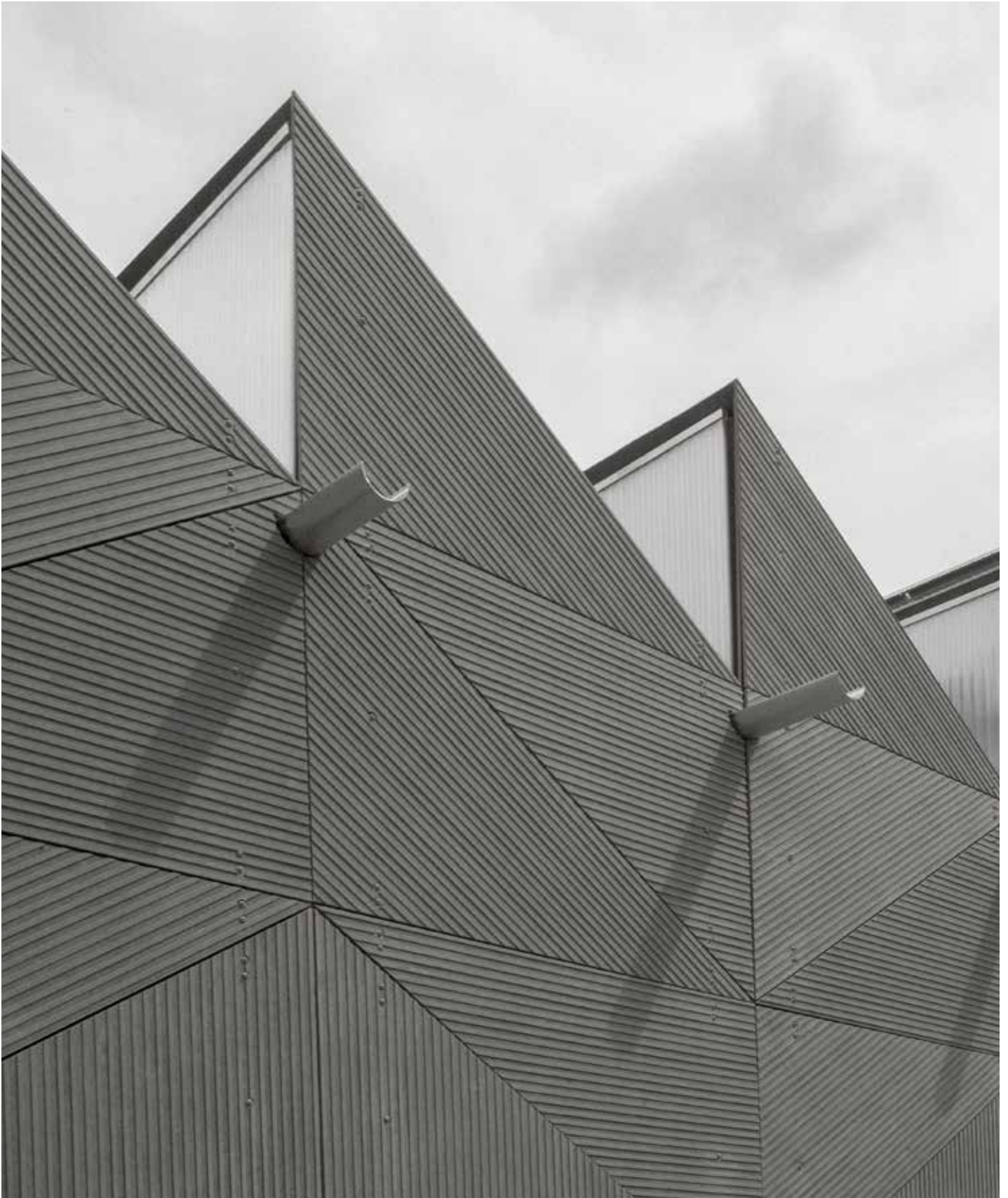
Clerkenwell Design Week London Pavillon Architekten: Studio Weave, London Produkt: EQUITONE [linea], grau LT 20 Foto: Etex Group
