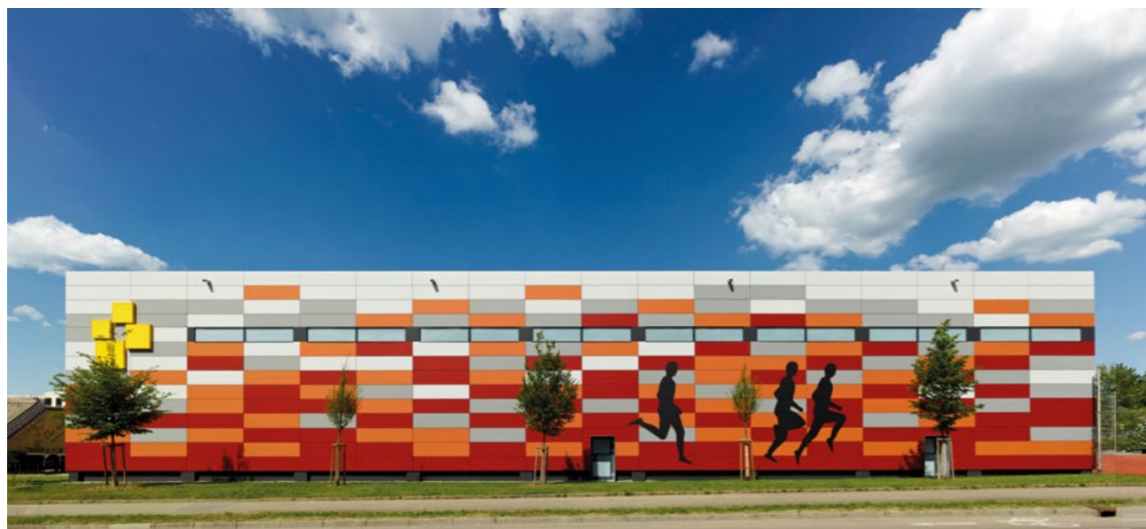
Arch.: KLE Freie Architekten BDA, Germany
