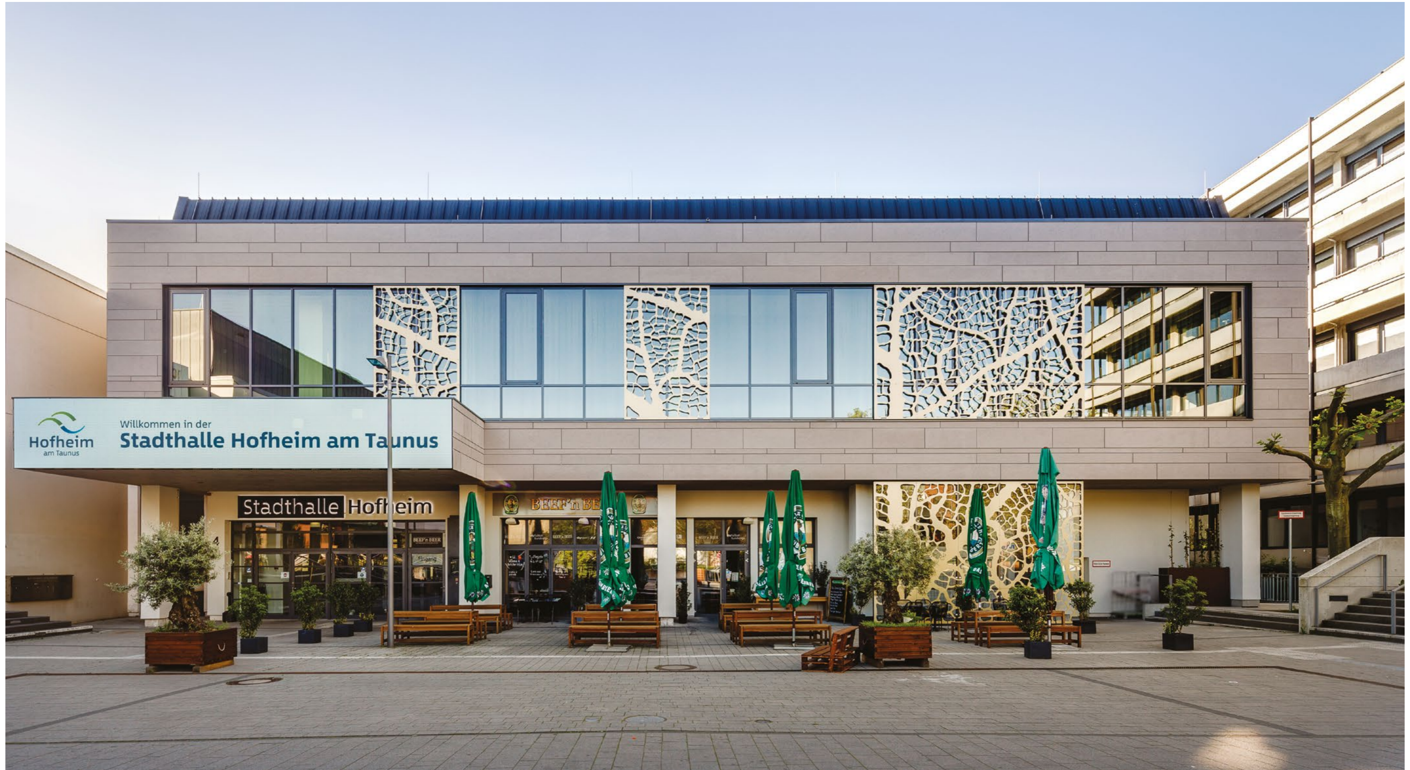
Arch.: Kulla Architekten, Hofheim, Germany
