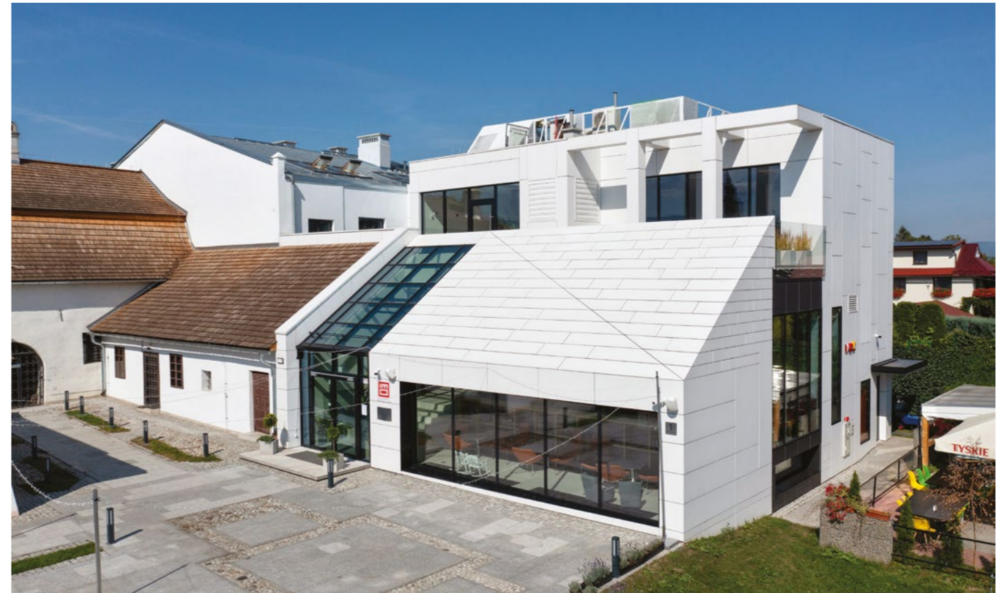
Arch.: 55Architekci, Stary Sącz, Poland
