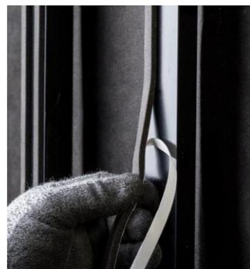
La bande de mousse adhésive UNI-Foam est utilisée en association avec des UNI-Rivets pour la fixation de panneaux de façade EQUITONE sur une structure portante en métal.
