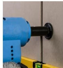
Pour éviter qu'il ne reste éventuellement des copeaux de forage en aluminium entre le panneau et le profilé, les rivets inférieurs ne peuvent être fixés qu'après élimination de tous les copeaux de forage en tapant délicatement sur le panneau.
